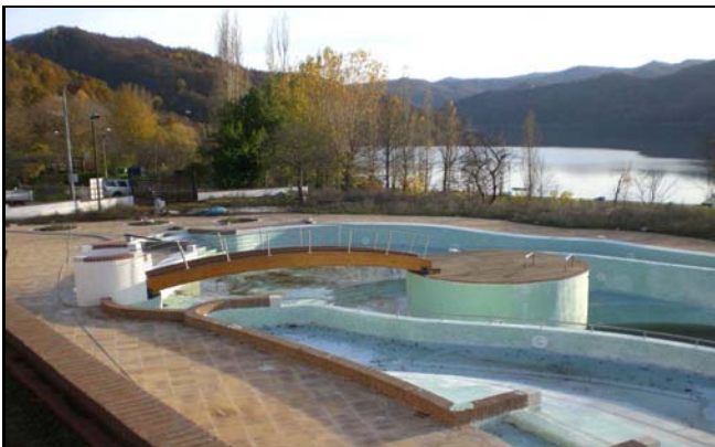
Piscina: zona tuffi e ponte
